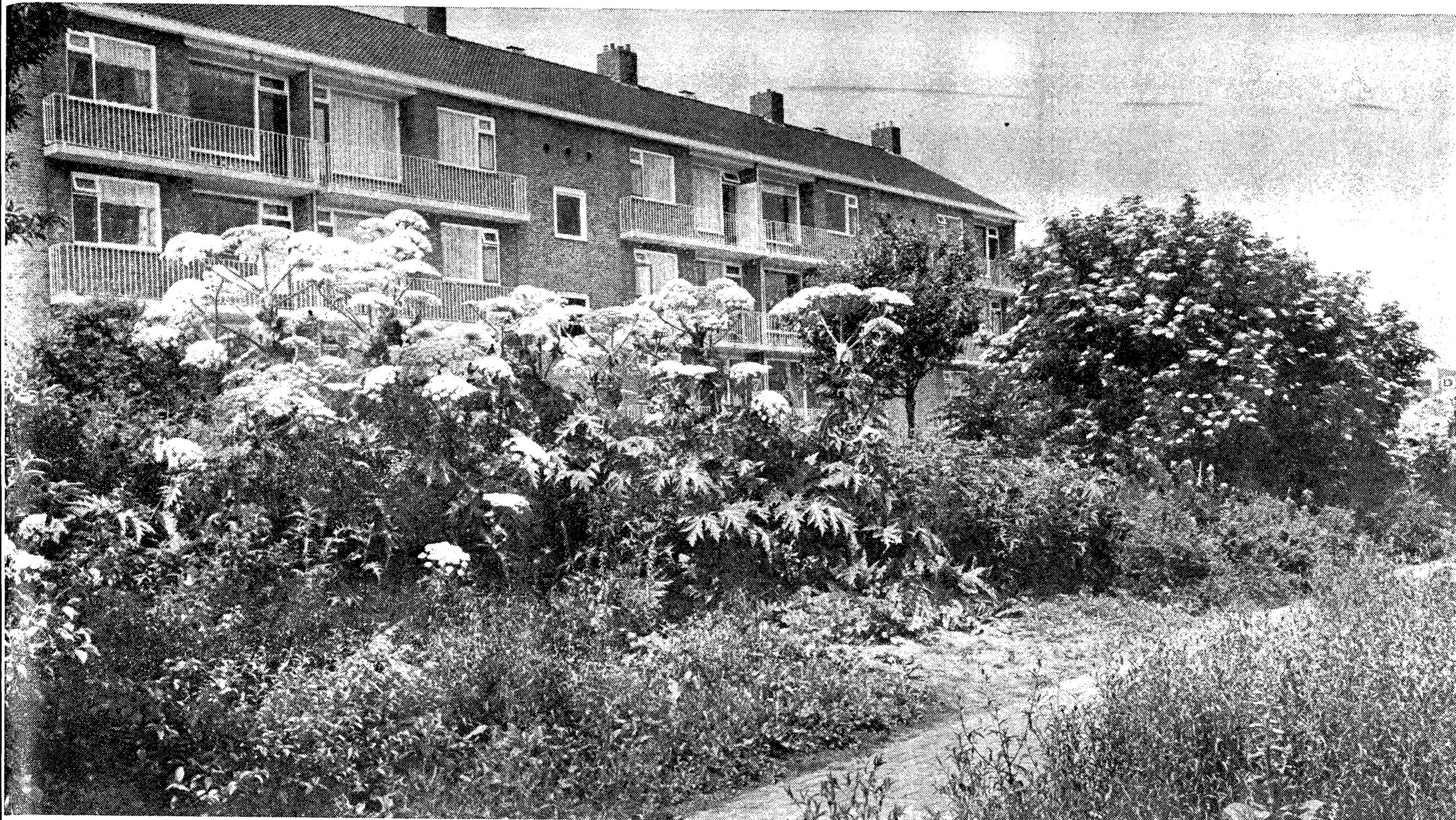
De pres. J. F. Kennedylaan te Heerenveen. Flats verdwijnen achter de weelderige begroeiing.
