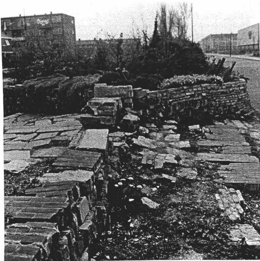
Fig.10: Niveauverschillen bij aanleg van de Kennedylaan
