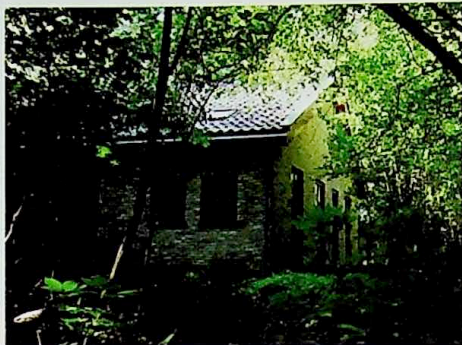
De voormalige werkplaats van Le Roy
