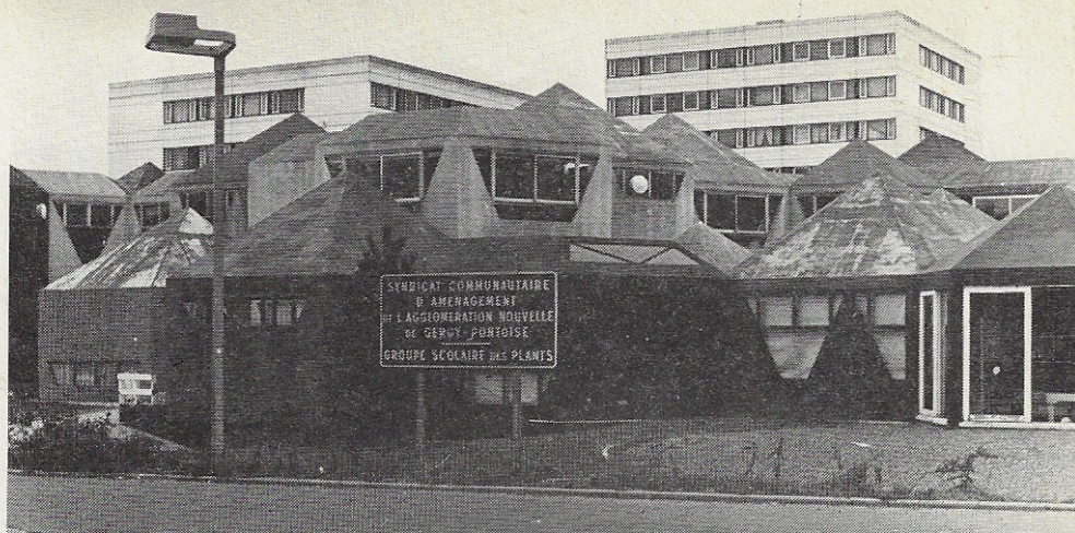
opnieuw zal het ambtelijk apparaat worden uitgedaagd om op het werkstuk van Renaudi -l'école des plants- te reageren nu zijn school dankzij noodzakelijke renoveringswerk-
