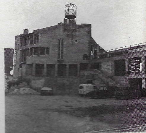
als het gebouw van het centre d'information door zijn gevarieerde architectuur op dezelfde wijze kan functioneren als de speciale burgerlijke bouwkunst van weleer, dan zal le paradis de Cergy daardoor iets kunnen worden uitgebreid
