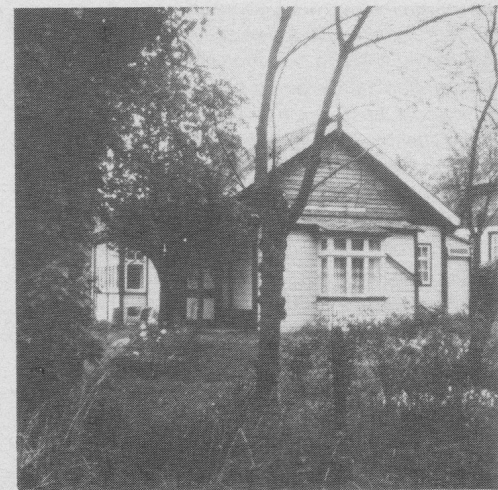
een uit Zweden geïmporteerde, geprefabriceerde cottage –Wilbury Road nr 122– dat thans nog bewoond wordt
