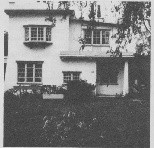
...evenals het niet minder beroemde, door Brodie ontworpen, gewapend betonnen woonhuis nummer 158 op Wilbury Road...
