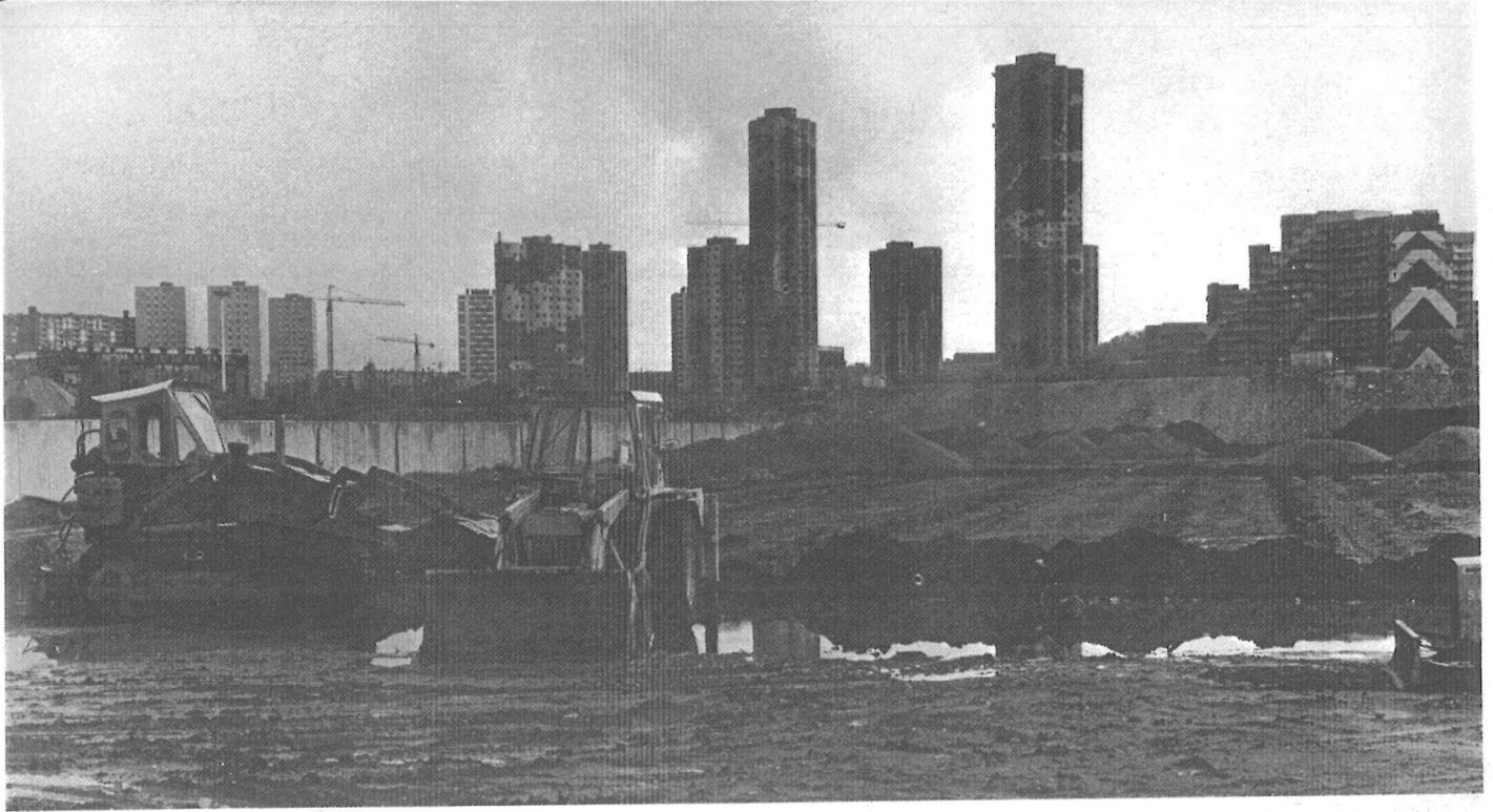
terreinwerkzaamheden in La Défense, op de achtergrond La Borne Gonflée
