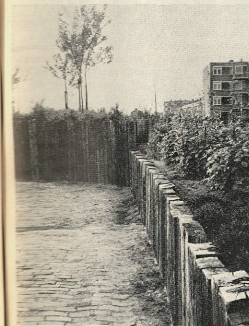
Niet alleen stenen, ook bielzen werden gebruikt om hoogteverschillen te creëren.
