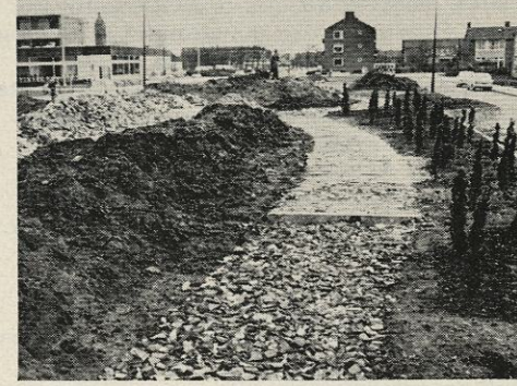
Stenen en grond worden gebruikt voor het maken van niveauverschillen in de strook aan de Kennedylaan in Heerenveen.
