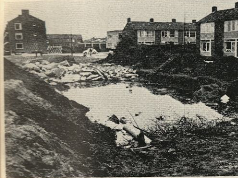
Eerste fase van het Kennedylaan-project aan de stadszijde; na verwijdering van de grond wordt puin aangevoerd waarmee niveauverschillen gecreëerd worden.
