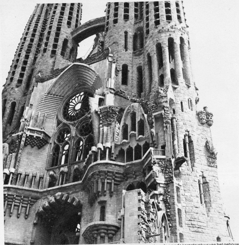
noordzijde (binnenkant) van de zuidelijke façade; veel structuren zijn toegepast om de amorfe kernstructuur van het gebouw te bedekken. (Zie foto, blokstructuur direct links van het linker spitsboogvenster en vergelijk deze met de aanzet voor een identieke structuur rechts van het naastgelegen spitsboogvenster)
