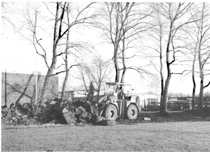
Bulldozer in actie bij het ruimen van de puintuin.
